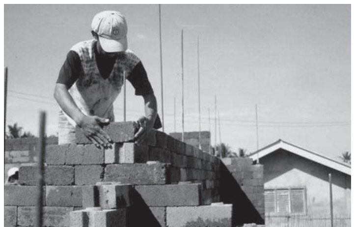
Mahalagang matutunan ng mga tao ang matibay na pamamaraan ng konstruksyon, para hindi na sila maging vulnerable sa susunod na bagyo o lindol. Ang compressed earth blocks ay isang material na matibay para sa dingding at madali ring itayo. Ginagamit ito ng Habitat for Humanity sa kanilang mga proyekto dahil sa pagiging “volunteer-friendly.” LARAWAN NI DANIEL MOSTRALES
